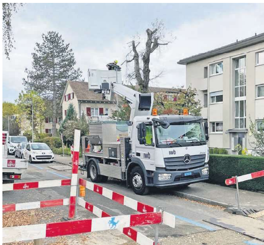
IWB-Monteur bei der Montage der LED-Leuchten.
