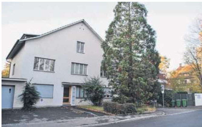
Das zum Abriss vorgesehene Wohnhaus an der Bahnhofstrasse 60, rechts sind der denkmalgeschützte Sieglinhof (Bahnhofstrasse 48) und der Neubau im Garten zu sehen.
