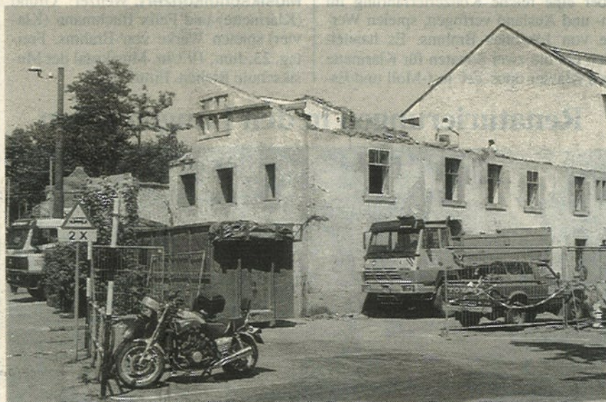
Das ehemalige Bauernhaus an der Ecke Baselstrasse/Gartengasse wird in ein Wohnhaus umgewandelt. (Foto Rolf Spriessler)
