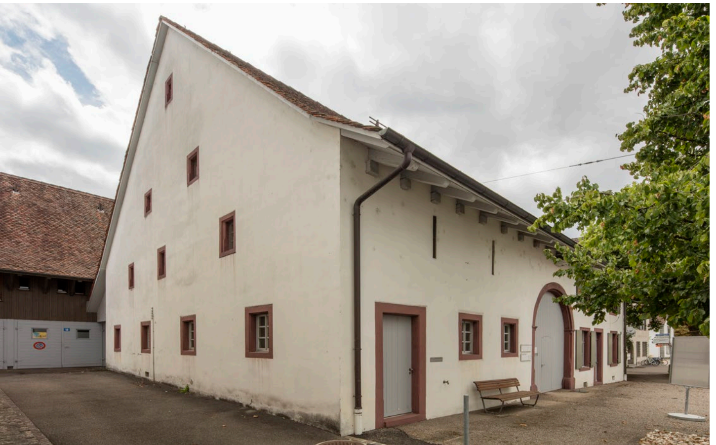
98. Das Haus Baselstrasse 12, links im Hintergrund die ehemalige Scheune (2017).
