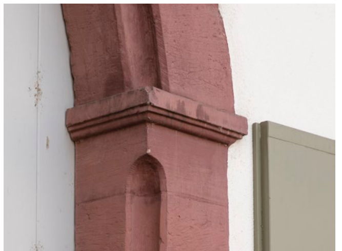
100. Scheunentor rechte Seite, mit nachträglich eingesetztem Bogenansatz (2017).
