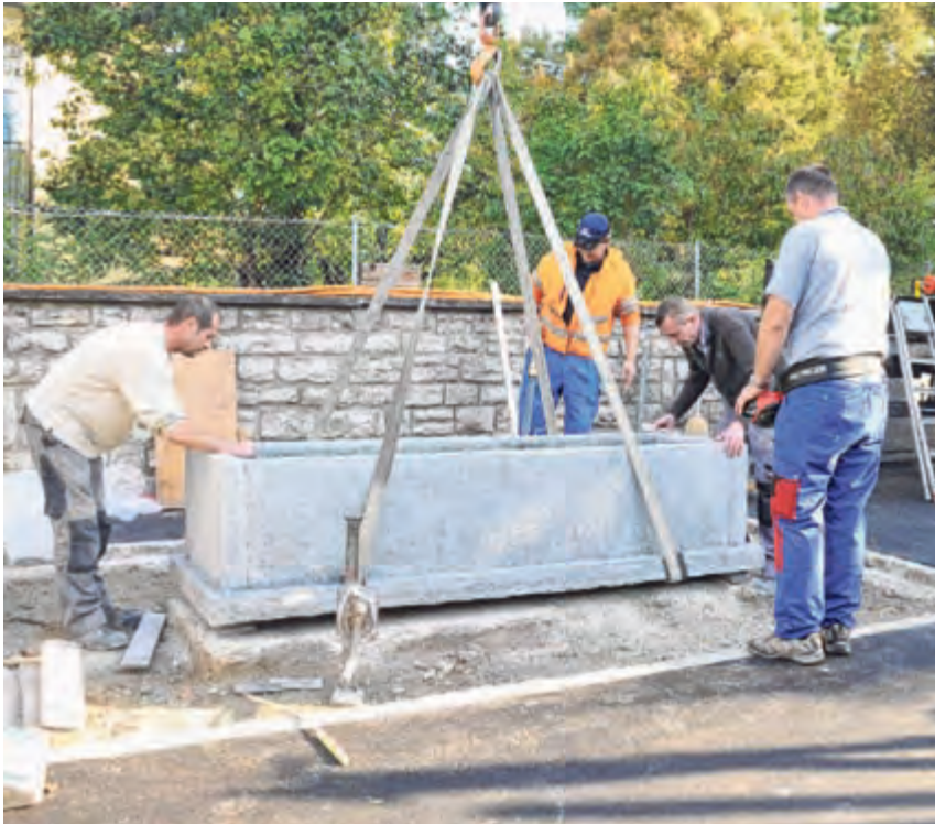
Zuerst wird der Trog gesetzt, dann schwebt der Brunnenstock mit der Skulptur heran.
