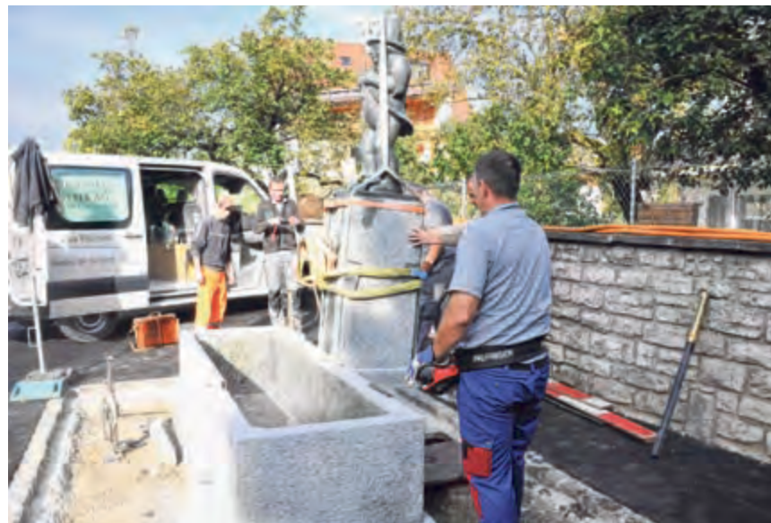
Der Brunnenstock wird neben dem Trog justiert.
