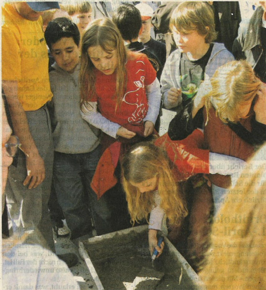
Einige der Schulkinder, die zuvor gesungen hatten, durften mit Hand anlegen, als der Grundstein einbetoniert wurde.
