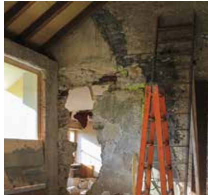
Künftige Gartenfassade, Wohnung Erdgeschoss.
