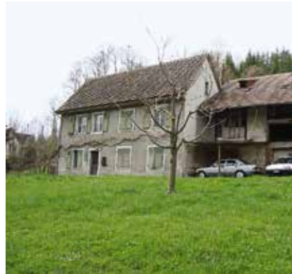
Zufahrt Eglingerweg von Süden, alter Zustand.
