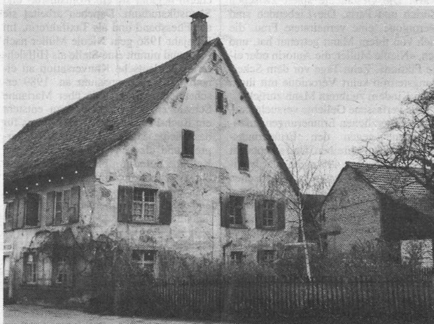
So hat das Schweizerhaus an der Rössligasse 19 vor Renovationsbeginn ausgesehen.
