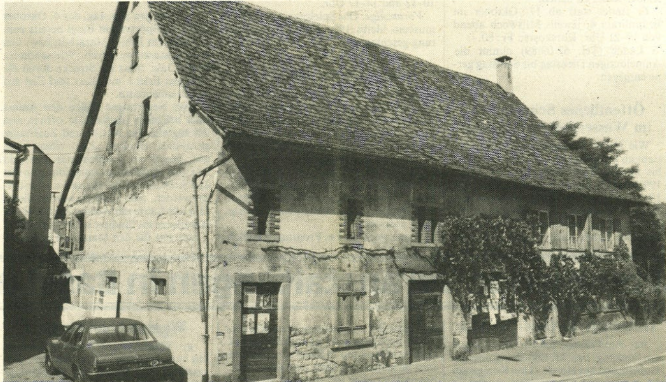
Das «Schweizer-Haus», dessen Dach und Fassade unter Denkmalschutz stehen, soll im Rahmen der Neugestaltung des Areals Gartengasse saniert werden. Nach Auskunft der Besitzer ist mit dem Beginn der Bauarbeiten 1991 zu rechnen.
