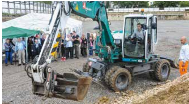
Humanitas, Grundsteinlegung vom 2. November 2015. Baukommissi- onspräsident Hans Martin Tschudi übergibt Direktorin Stefanie Bollag symbolisch einen Spatenstich. Den ersten Spatenstich macht ein Bagger.
