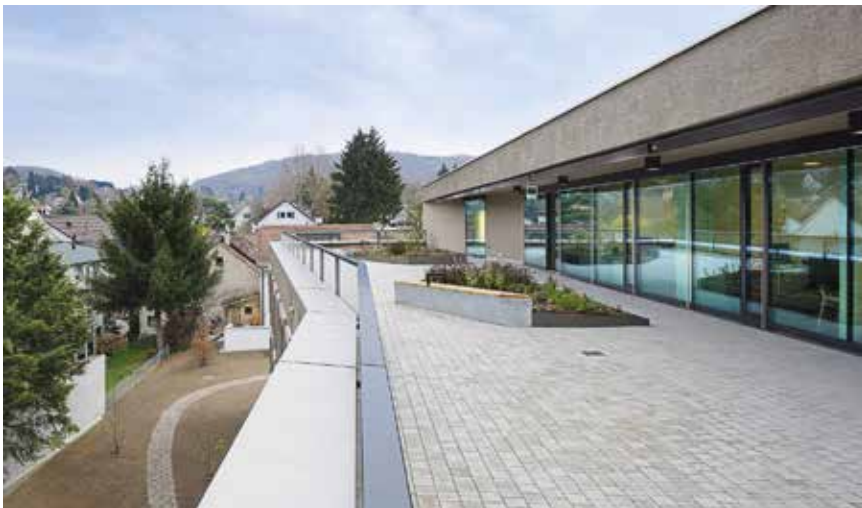
Adullam-Neubau: der Eingangsbereich mit Empfang, Foyer und Restaurant. Den Gästen des Adullam stehen grosszügige Terrassen zur Verfügung.
