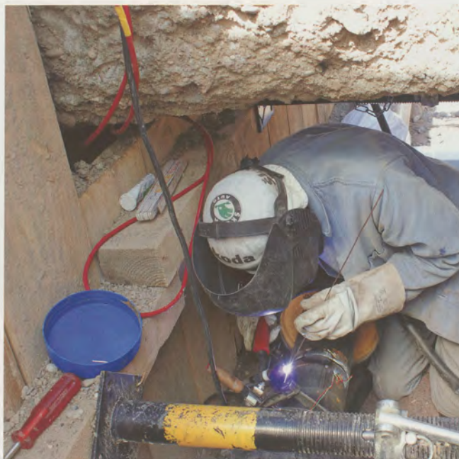
Schweissarbeiten am Fernwärmerohr unter engen Platzverhältnissen.
