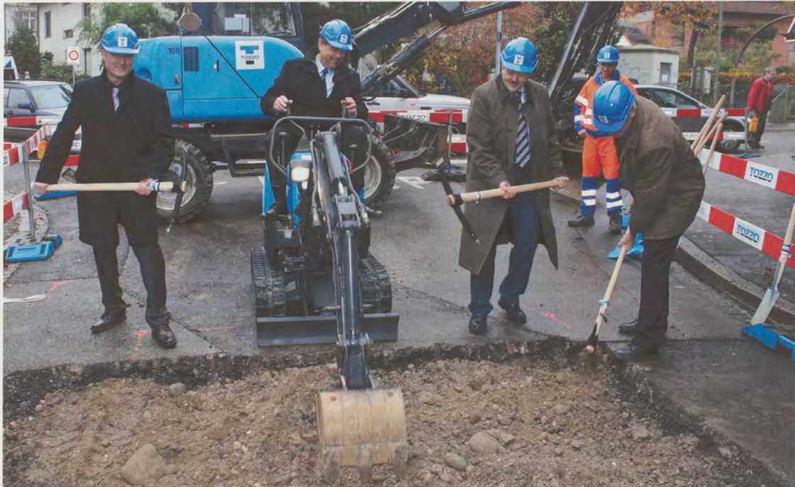
Spatenstich für den Leitungsbau am 10. November 2009. v.l. Jürg Kunz, Geschäftsführer Wärmeverbund Riehen AG, Marcel Schweizer, Präsident Verwaltungsrat Riehen AG, Heinrich Schwendener, Mitglied Geschäftsführung IWB, Willi Fischer, Gemeindepräsident Riehen.
