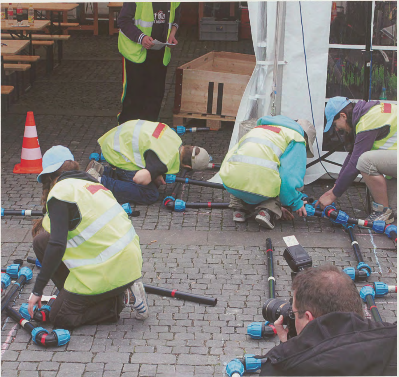
Erdwärmefest vom 20. März 2010. Am Wettbewerb massen sich junge Teams beim Rohrverlegen.
