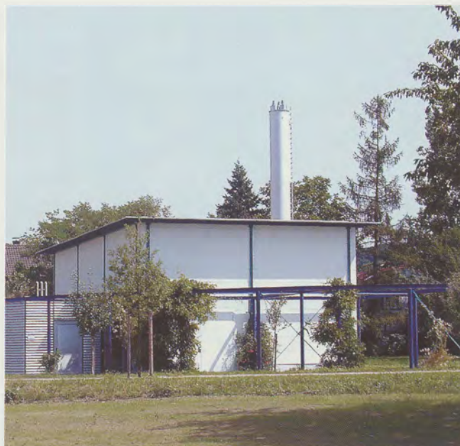
Die Heizzentrale in Stetten Süd.
