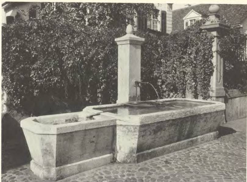
Brunnen vor der alten Post, 1855
