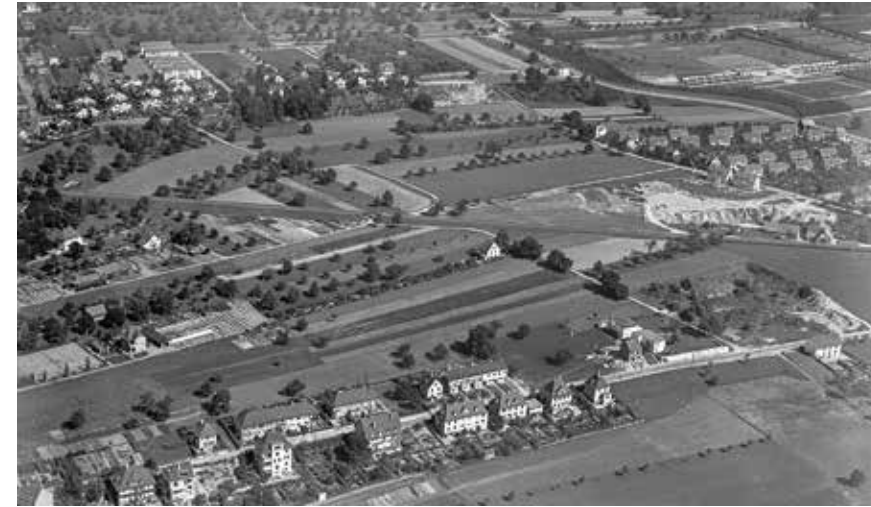
Flugaufnahme von 1934: Unten im Bild liegt die Niederholzstrasse, in der Mitte das Haus am Langenlängeweg 35, darüber durchquert die Wiesental-Strecke die Landschaft. Rechts ist die Kiesgrube am Rüchligweg zu sehen, ferner die Siedlung der «Heimstätte-Genossenschaft Niederholz» an der Schäferstrasse und der Hörnli-Gottesacker.
