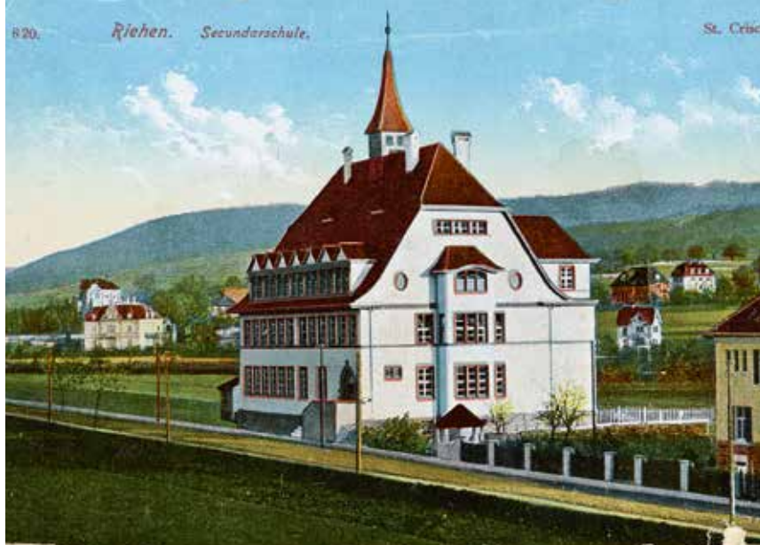
Das Burgschulhaus vor der baulichen Erweiterung von 1930, Ansichtskarte
