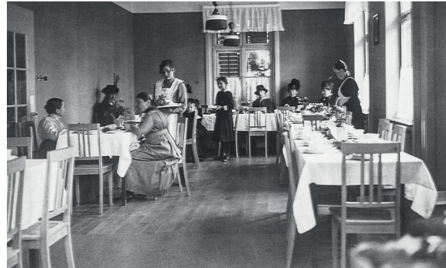
Essraum im 2. Obergeschoss, 1919.
