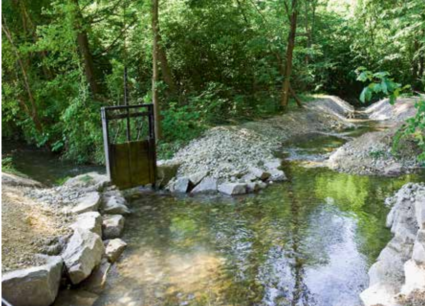
Das Ende der Neubaustrecke bei den Spittelmatten. Nach der Einmündung des Abflusses der Entenweiher verzweigt sich das Gewässer nach der Neubaubrücke wieder: links die Abzweigung in den Spittelmattbach entlang des Waldrands, geradeaus der Rückfluss des Alten Teichs in den Neuen Teich.
