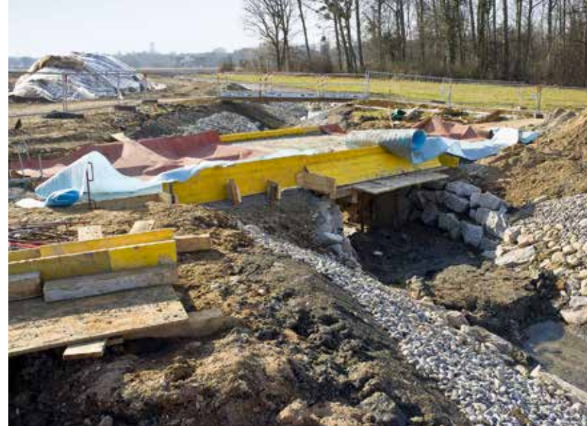
Brückenbau über den Alten Teich beim Breitmattweg
