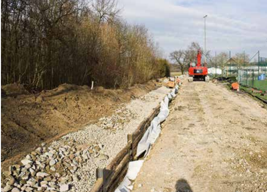
Die engen Platzverhältnisse zwischen den Sportanlagen Grendelmatten und der dortigen Wasserstelle der IWB: Für den Bau mussten das Kunstrasenfeld teilweise und das Ballfangnetz ganz entfernt werden.
