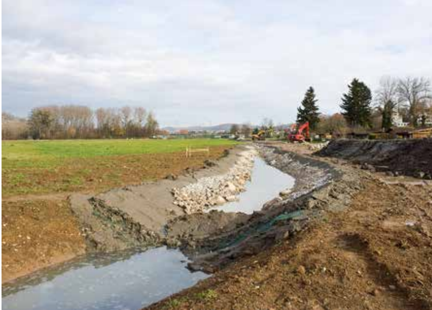
Das neue Bachbett beim Breitmattweg. Gut sichtbar sind die Auskleidung mit Opalinuston zur Abdichtung gegen das Grundwasser sowie die Beschichtung mit Flusskiesel.
