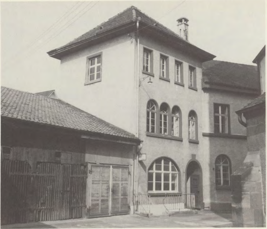
Der turmartige Abschlussbau von 1918 gegen die Kirche hin. Zustand ca. 1976.
