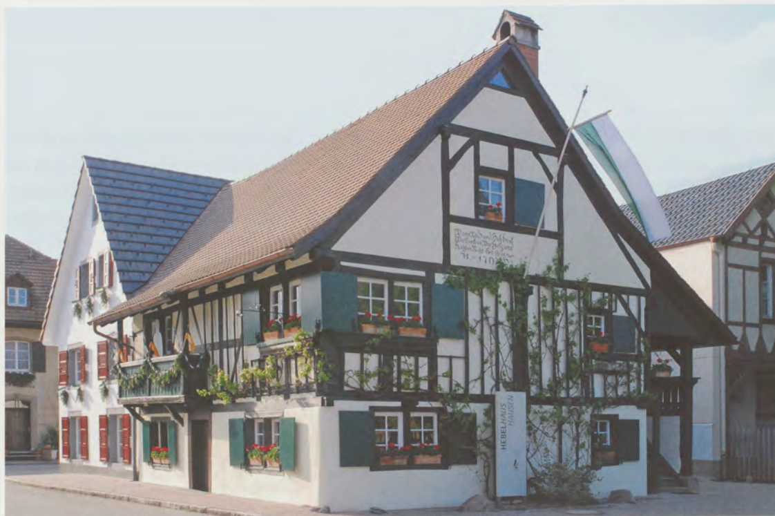
Das frisch sanierte Hebelhaus in Hausen nach der Neueröffnung im Mai 2010.
