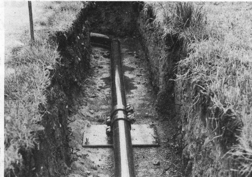
Am Lettackerweg ist die Verbindungsleitung für die Rückführung des Wassers von der Bohrstelle Bachtelenweg zur Bohrstelle Stettenfeld im Bau, wo es in die Erde zurückgeleitet wird. Foto Philippe Jaquet
