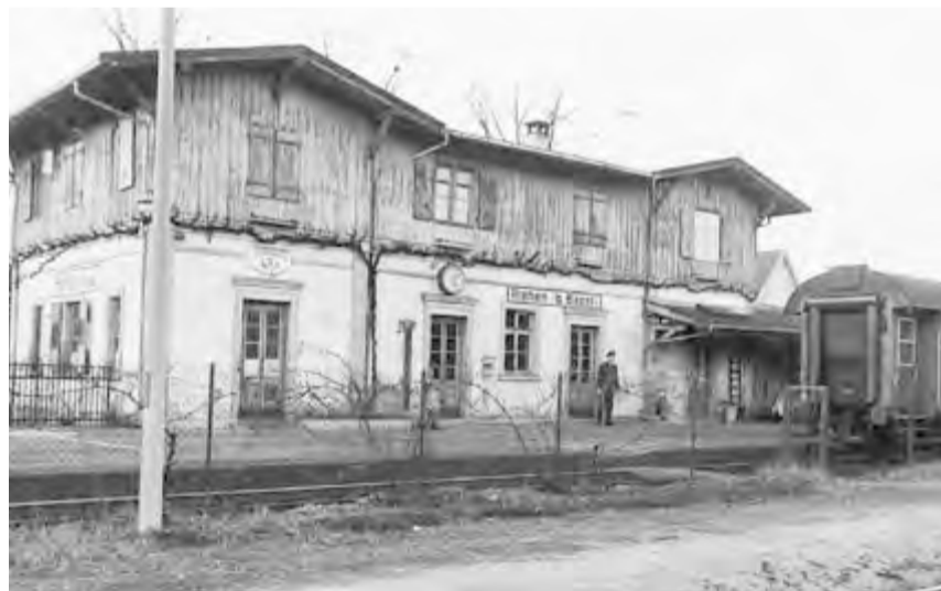
Das 1862 erbaute Stationsgebäude (Bild) wurde 1972 abgebrochen. An seiner Stelle wurde die Post Riehen 1 errichtet. Einst hatte der Bahnhof zu den fünfzehn wichtigsten Bahnhöfen des Grossherzogtums Baden gezählt, versank dann aber nahezu in der Bedeutungslosigkeit. Fotos: Dokumentationsstelle Riehen
