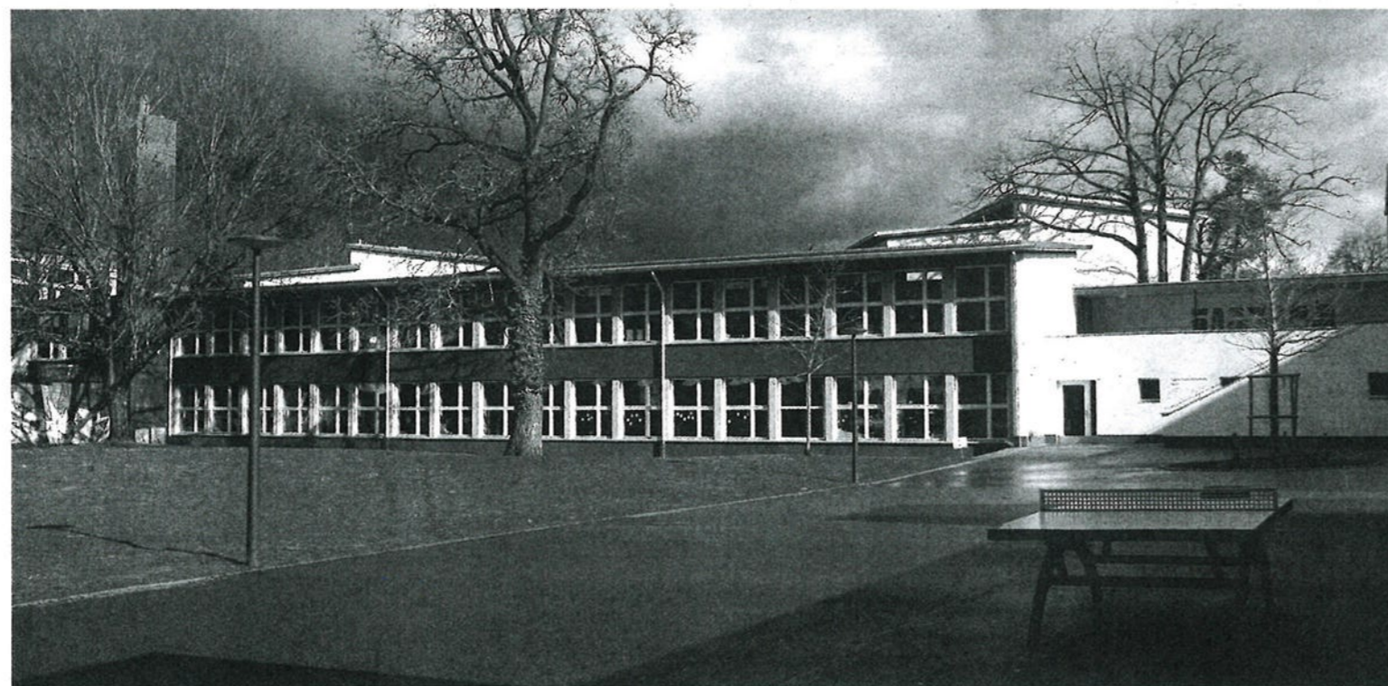
Schulhaus Niederholz. Hier muss kurzfristig neuer Schulraum geschaffen werden.
