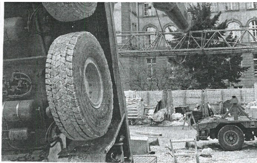
November 2009. Beim Abbau des roten Krans kippte der Pneu- -kran um. Foto Muchenberger
