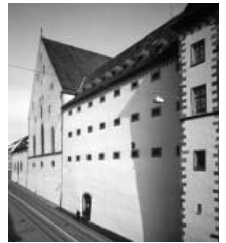
Die Westfassade des Lohnhofs am Kohlenberg.
