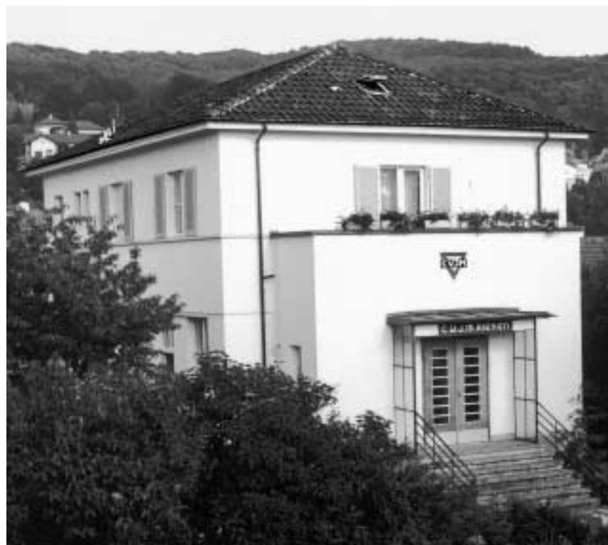
Das CVJM-Kornfeldhaus (Kornfeldstrasse 83), 1934 von Vereinsmitgliedern erbaut, das heute für Vereinsanlässe und für die Jugendarbeit genutzt wird.
