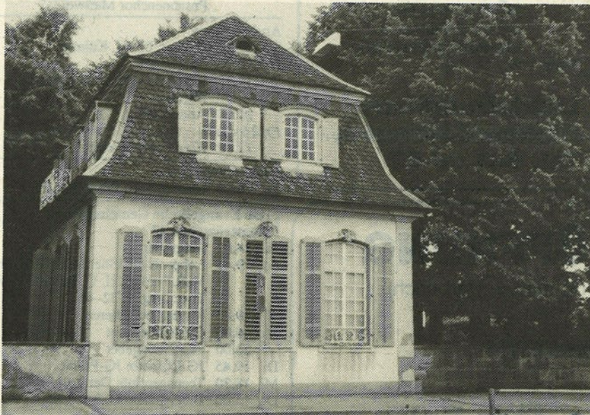
Im unter Denkmalschutz stehenden Cagliostro-Pavillon an der Aeusseren Baselstrasse soll eine Vierzimmerwohnung eingerichtet werden. (Archivbild)
