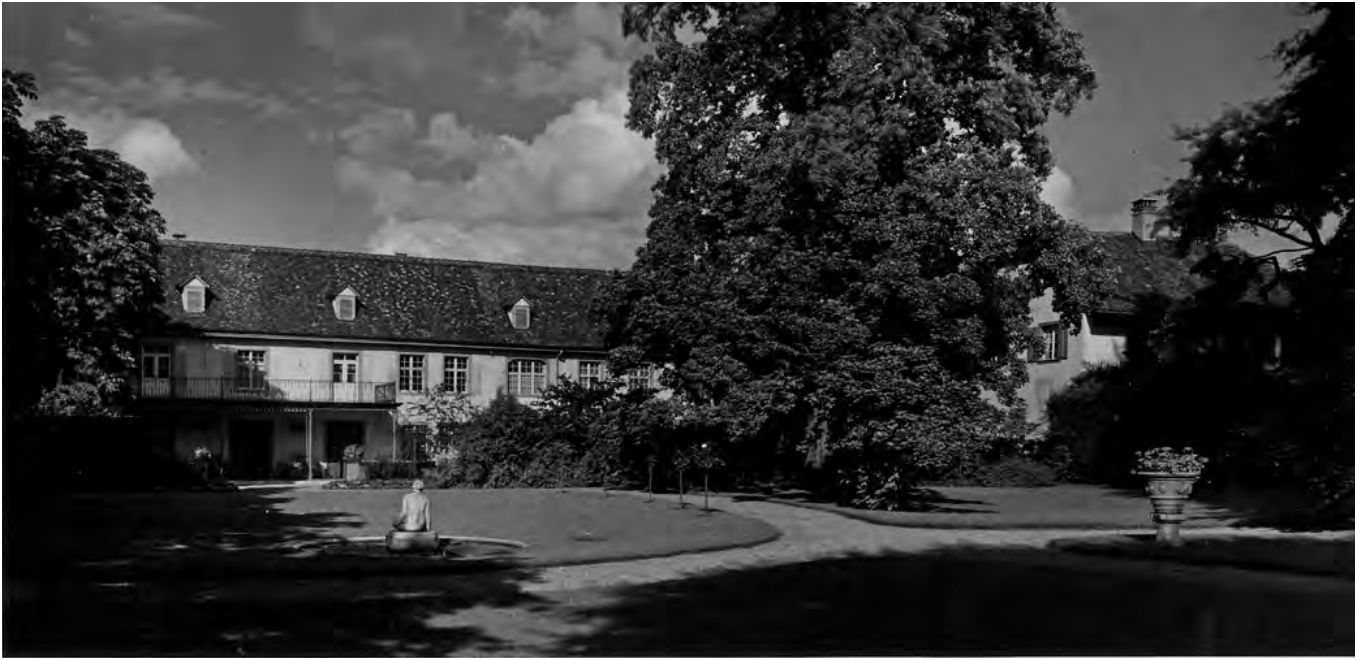
83. Gartenfassade des Herrschaftshauses, Ansicht vom Englischen Park aus (1963).
