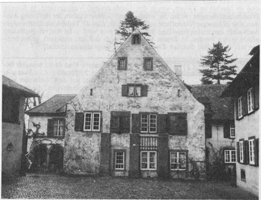
Der Alte Wenken kurz vor der Renovation. Das Haus hatte vorher einen schönen Efeu-Bewuchs.
