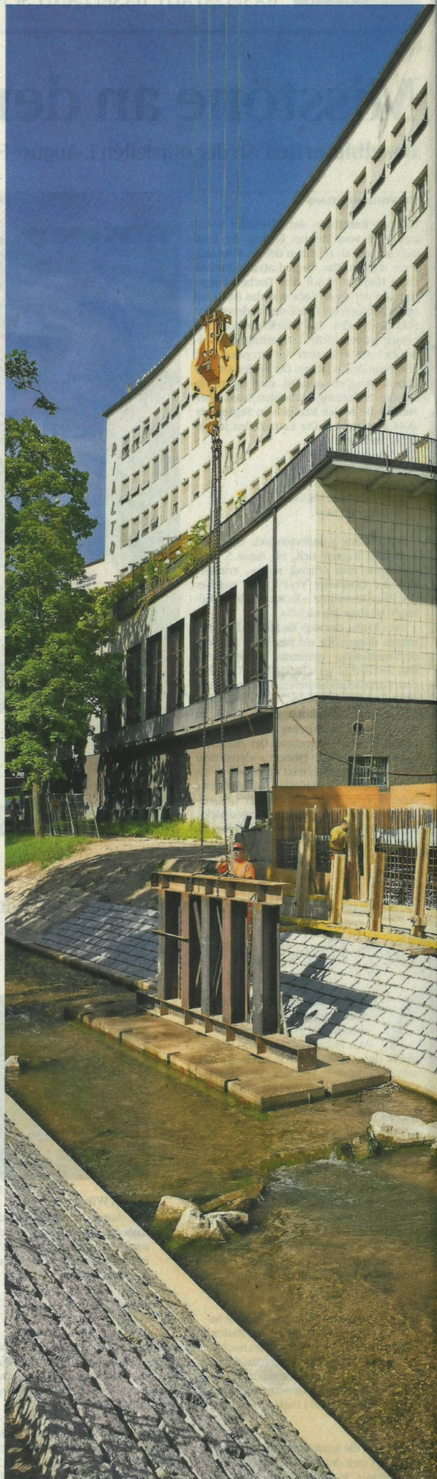
Nur weil der Mensch bauen will, hört der Birsig nicht auf zu fließen. Die drei Brücken Fluss hineingebaut werden. Hochwasser, Niedrigwasser und Schwankungen der Lu
