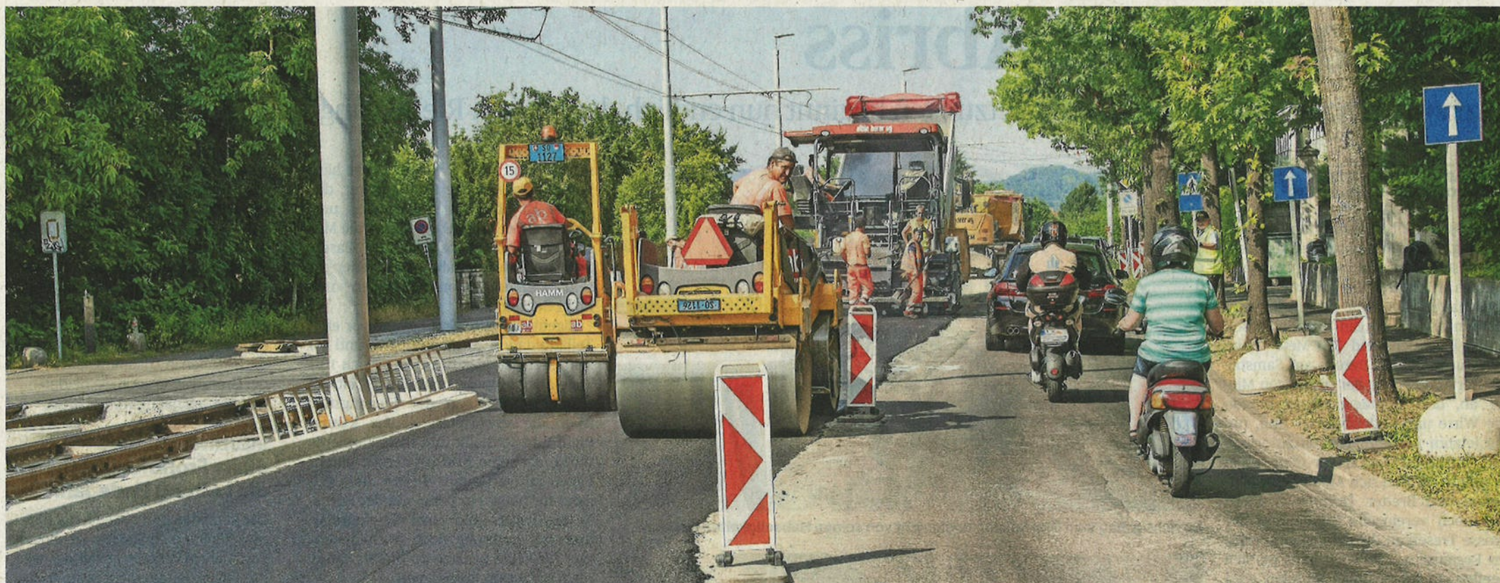
Zankapel Äussere Baselstrasse: Riehens Hauptachse wird derzeit aufwendig saniert.
