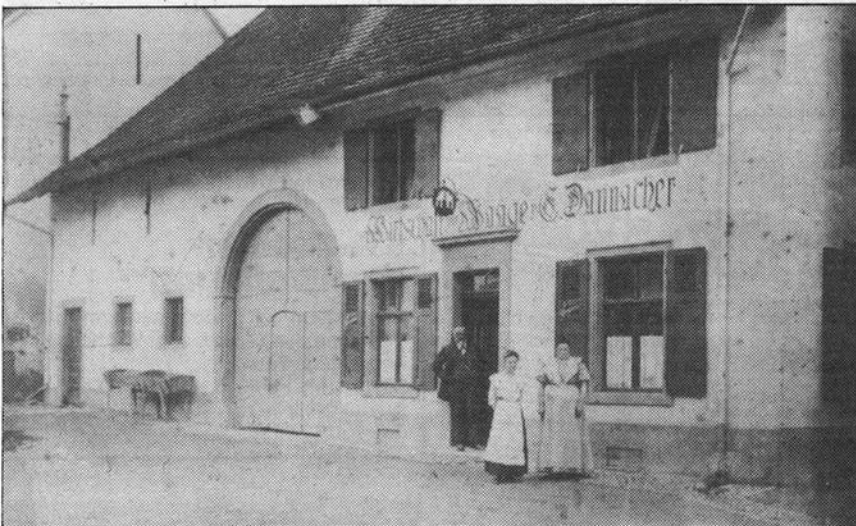
Im Haus «Zur Waage», Baselstrasse 12, befand sich früher auch eine Gaststätte. Bilder: Sammlung Johannes Wenk-Madoery.
