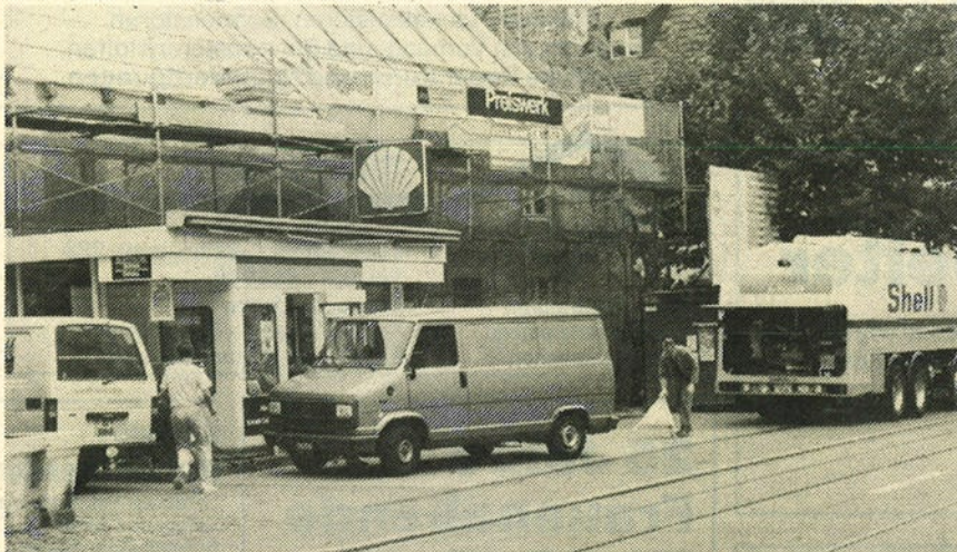
Die Shell-Tankstelle vor dem im Umbau begriffenen «Haus zur Waage» an der Baselstrasse. Foto Philippe Jaquet
