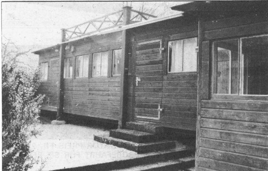
Zwei ehemalige Baubaracken werden am Moosweg von der Gemeinde zu Pfadilokalen hergerichtet. Foto Philippe Jaquet.
