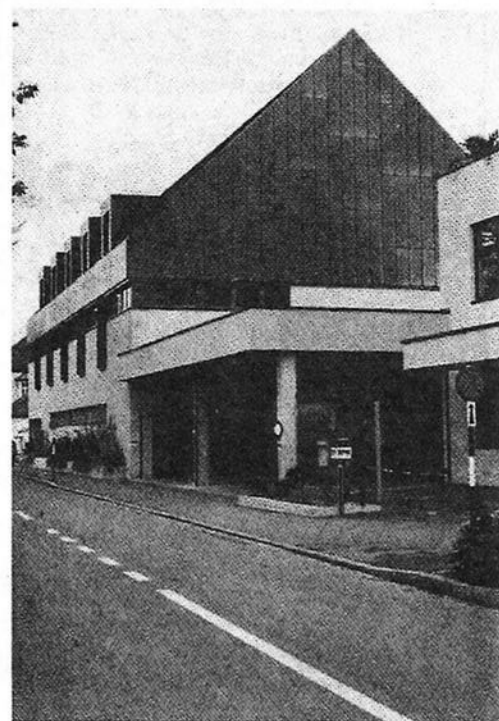
Die neue Telefonzentrale an der Bahnhofstrasse von der Schlipferhalle her gesehen.
