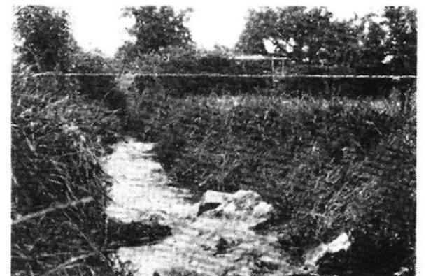
Bewässerungsgraben im Brühl
