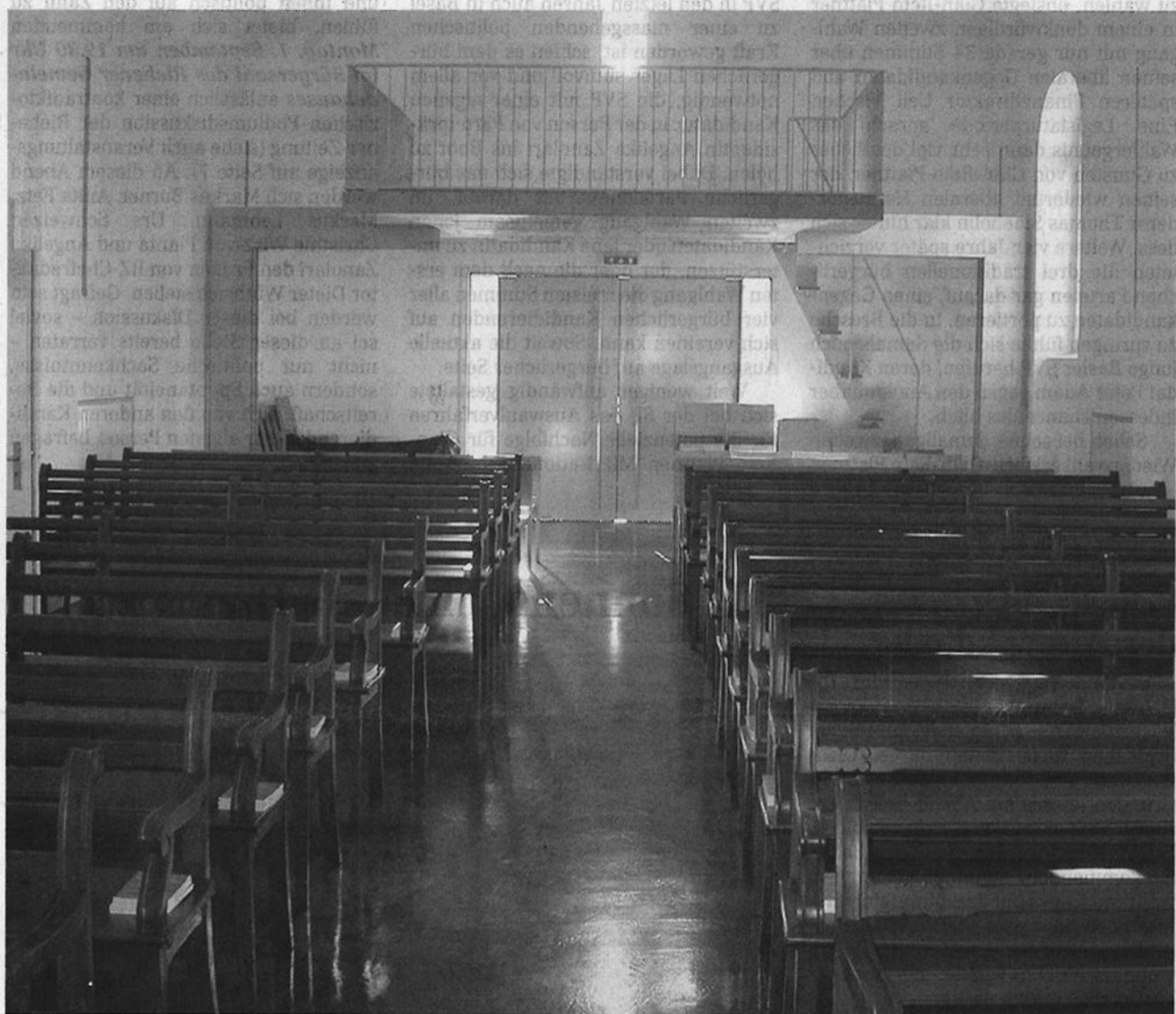
Blick in die nun als durchgängiger Raum konzipierte Kapelle. Eingebaut wurde auch eine Empore, auf der die neue Orgel aufgebaut wird. Der Fussboden besteht aus schwarzem Gussasphalt
