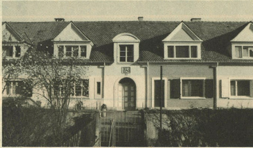
Die typischen Reihenhäuser im Hirzbrunnenquartier, Baujahr 1925
