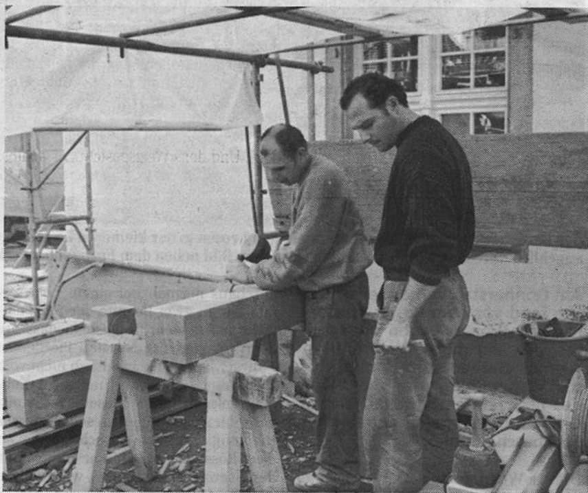
Die historische Bausubstanz der Berower-Ökonomien stellt hohe Anforderungen an die Handwerkskunst. Hier bearbeiten zwei Zimmermänner gerade einen massiven Holzbalken.
