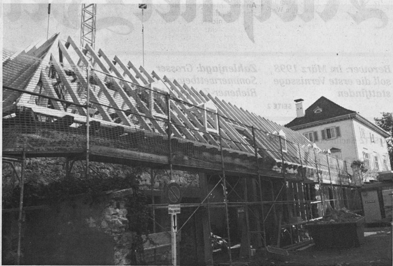
Auch im hinteren Teil der Berower-Ökonomiegebäude schreiten die Sanierungsarbeiten zügig voran. Gut erkennbar ist der neue Dachstuhl mit den Lukarnen.
