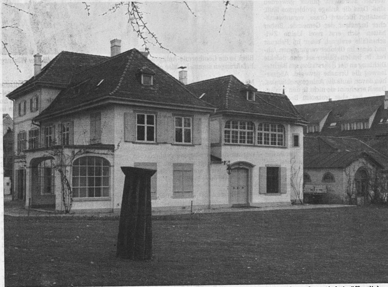
In der Berowervilla, die in den letzten Jahren die Kunstausstellungen der Gemeinde beherbergt hat, wird ein öffentliches Café/Restaurant entstehen. Die später angebaute Veranda (links im Bild) wird abgerissen. Foto: Dieter Wüthrich
