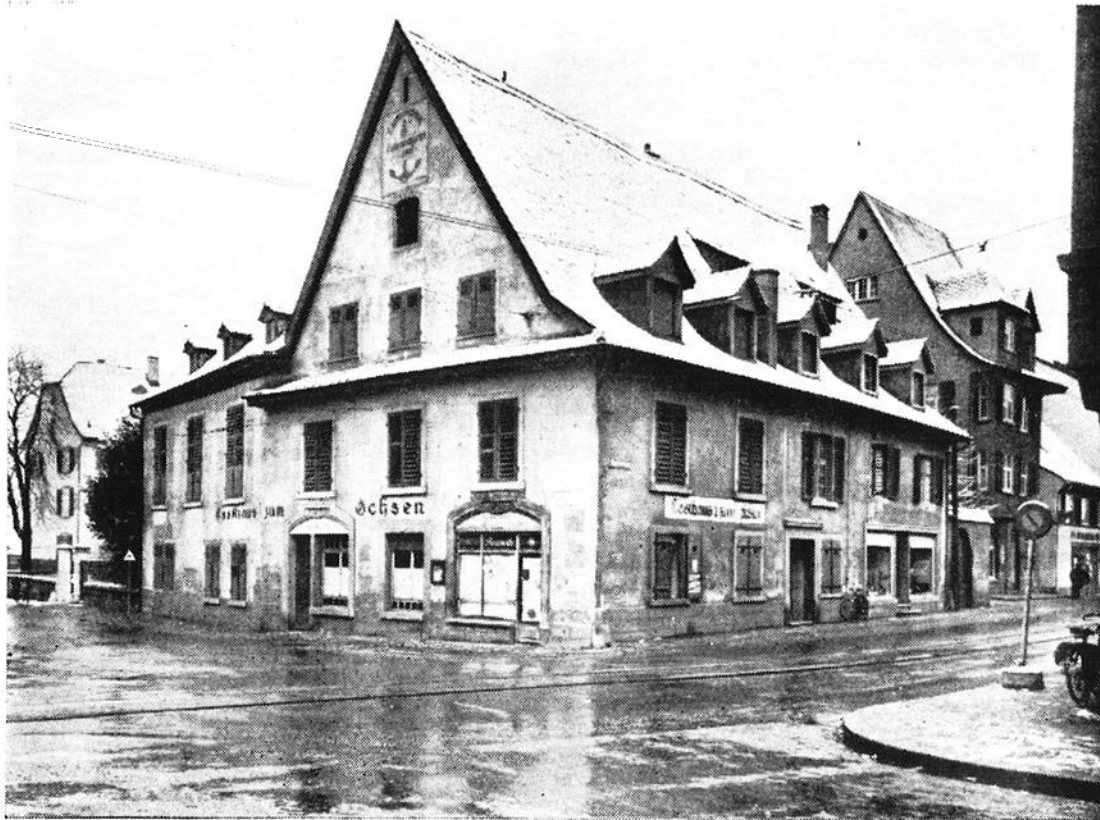
Der Ochs vor dem Abbruch
