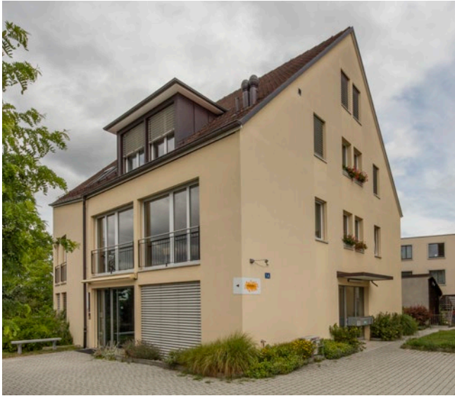
12. Haus Baselstrasse 1a (2017).
