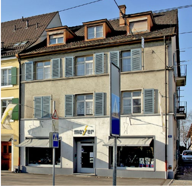
13. Haus Baselstrasse 3 (2004). Links anschliessend: Haus Baselstrasse 1.
