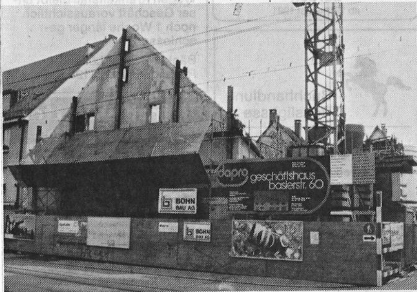
Hinter der Giebelfassade des alten Bauernhauses entsteht ein neues Gewerbe- und Bürohaus. Fotos Dieter Wüthrich
