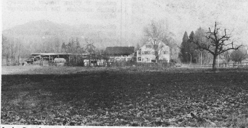
In der Grundwasserschutzzone zwischen dem Dorfrand und der Wiese ist das überbaute Areal der Schreinerei Wirz ein Fremdkörper. Foto Christoph Rytz
