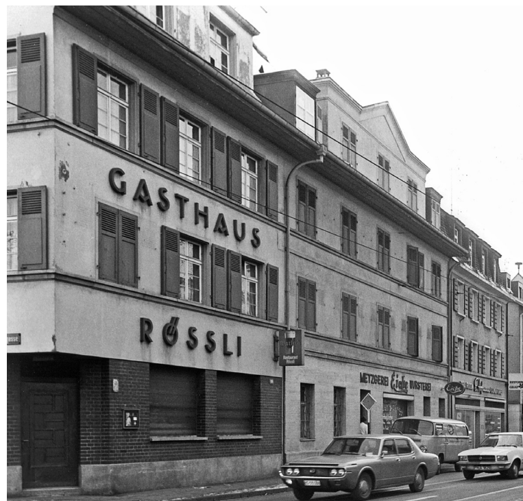
125. Das «Rössli» nach dem weitgehenden Neubau von 1928–1931: Die Fassade gegen die Baselstrasse (1976, kurz vor dem Abbruch).
