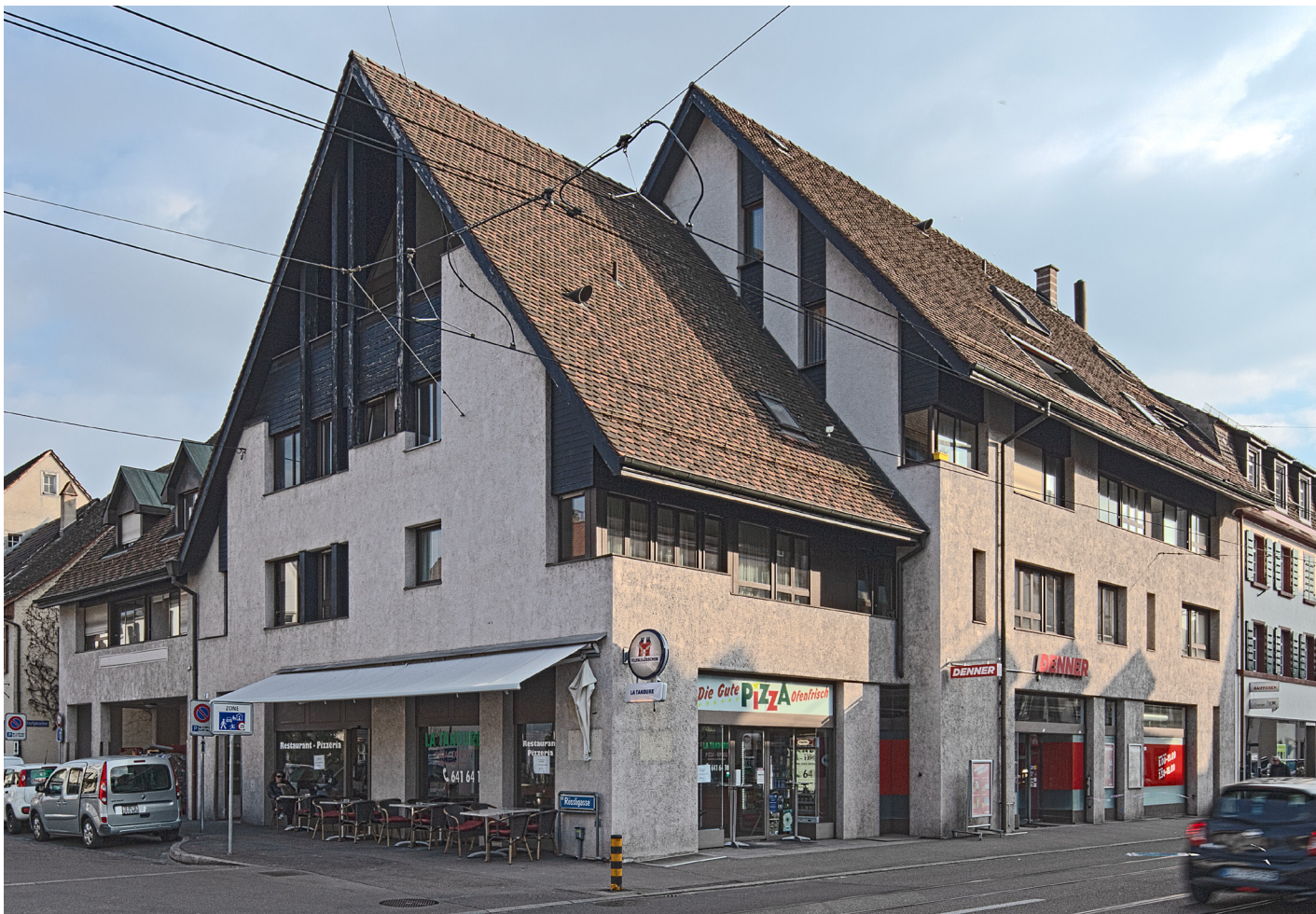
126. Eckansicht Rössligasse/Baselstrasse des Gebäudes Baselstrasse 58 / Rössligasse 2 (2022).
