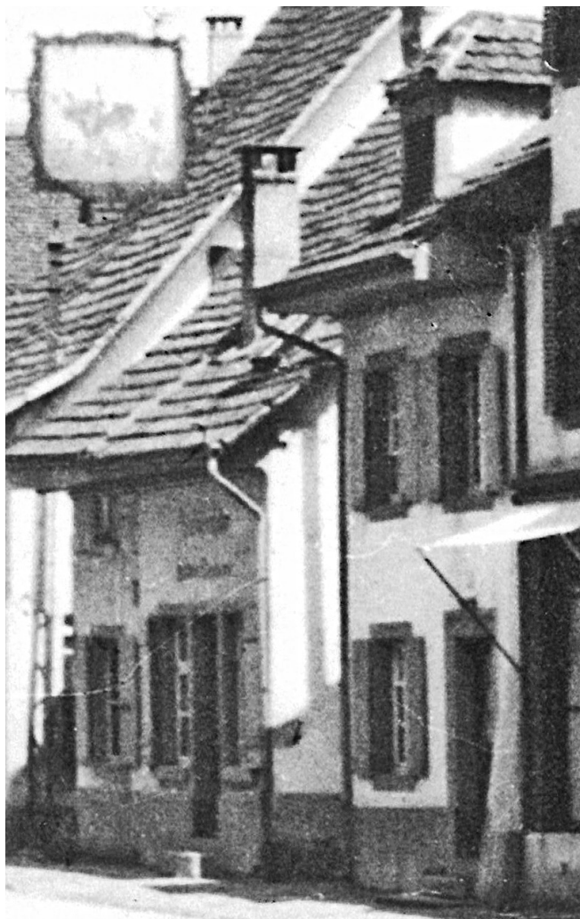
112. Baselstrasse 52 (1925/29). Links das Werkstattgebäude an der Stelle der ehemaligen Scheune, rechts das Wohnhaus, dazwischen der Durchgang zu Baselstrasse 54.
