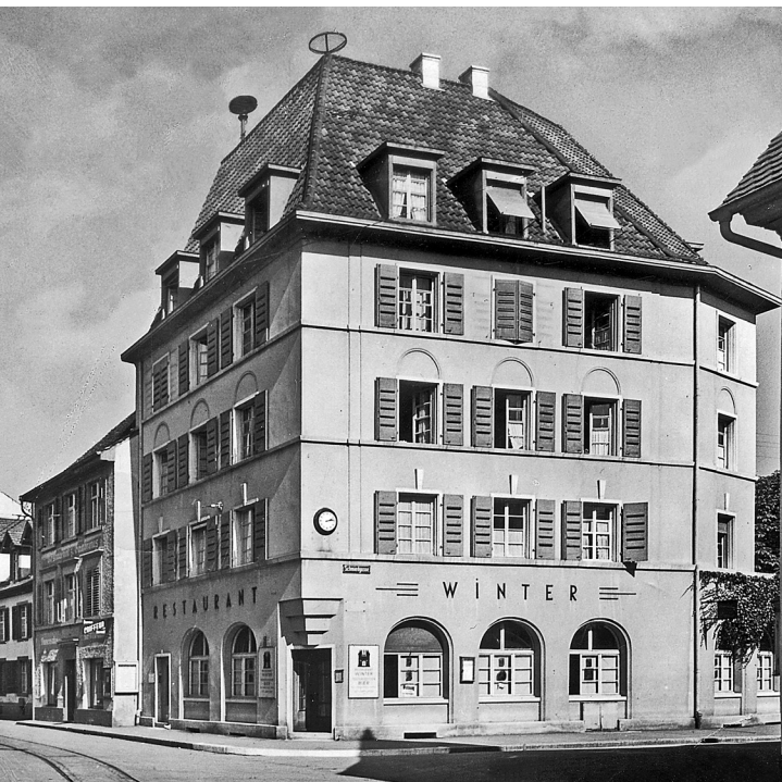
107. Links das Haus Baselstrasse 48 von 1841, rechts die Eckansicht des 1928 errichteten Restaurants Winter (zwischen 1935 und 1954).
