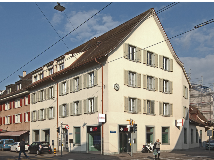
108. Die Ecke Baselstrasse/Schmiedgasse, im Zustand der Umgestaltung von 1993. Rechts der Flügelbau an der Schmiedgasse, hinter dem sich der ehemalige Kinosaal verbirgt (2022).
