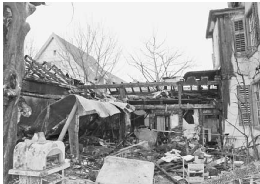
Blick in das ausgebrannte Nebengebäude von Osten her.
