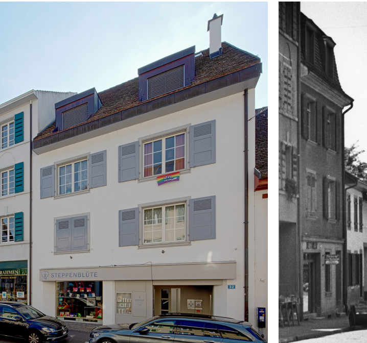
88. / 89. Schmiedgasse 32; links die Strassenansicht 2022, rechts die Fassade mit dem ursprünglichen Mansarddach (1935).
