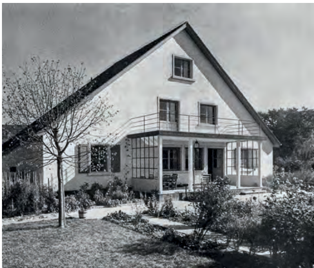
Emil Bercher, Eugen Tamm, Wohn- und Atelierhaus Stoecklin, Morystrasse 6, 1928. Ansicht der Gartenseite. Stoecklins zweigeschossiges Atelier mit grossem Dachfenster befand sich in der linken Haushälfte.
