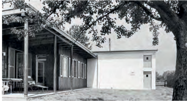
Paul Artaria, Wohn- und Atelierhaus Barth, Vierjuchartenweg 24, 1935/36. Gartenseite des Hauses mit Wohntrakt (links) und Atelier (rechts), vor 1940. 1941 wurde der Wohntrakt von Bräuning, Leu, Dürig um ein Geschoss erhöht.
