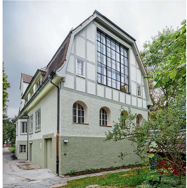
Emil Faesch, Wohn- und Atelierhaus «Zum Mohr», Äussere Baselstrasse 186, 1912. Nördliche Giebelseite mit dem grossen Fenster des Ateliers von Emil Gerster.
