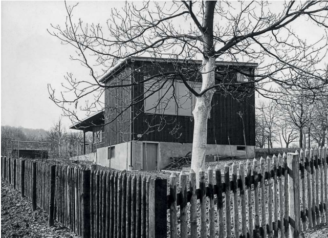
Paul Artaria, Hans Schmidt, Wohn- und Atelierhaus Wenk, Mooshaldenweg 5, 1926. Ansicht vom Mooshaldenweg kurz nach Fertigstellung.
