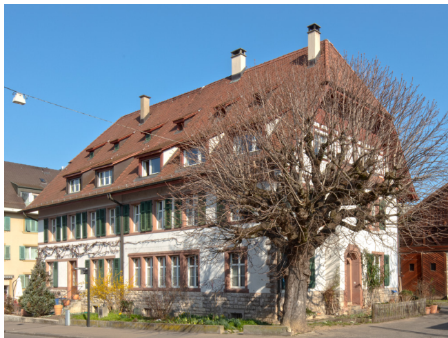
50. Das Doppelhaus Schmiedgasse 31–33 / Wendelinsgasse 2, Eckbereich Schmiedgasse/Bahnlinie (2022). Siehe auch Abb. 231–232.
